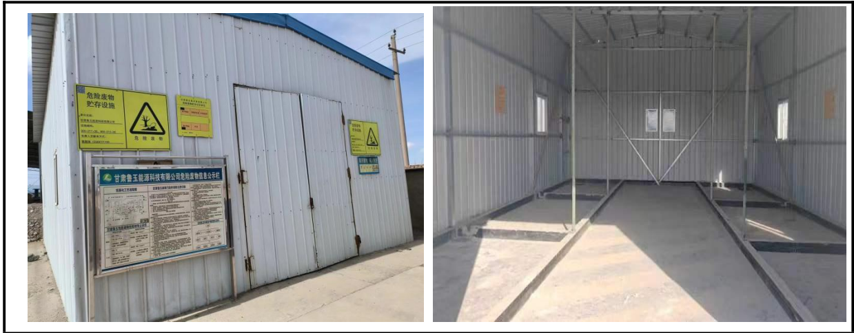
图 4.1-3 危险废物暂存间
