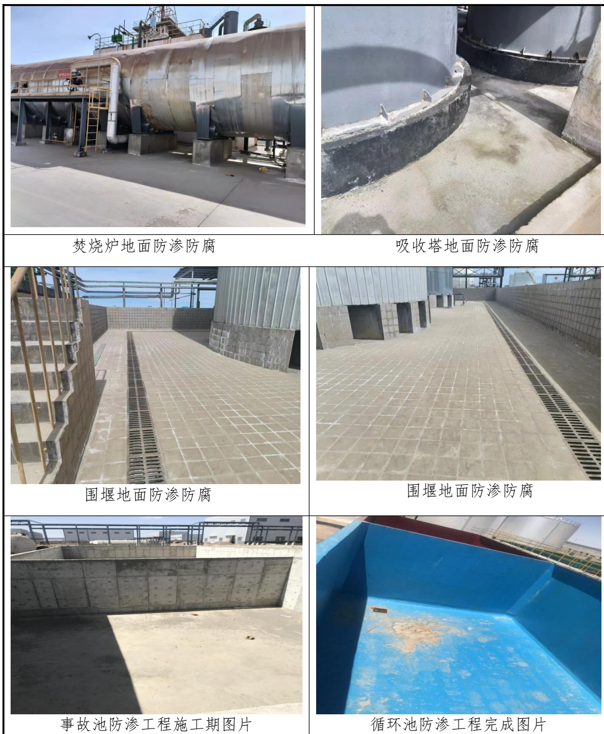
图 4.3-1 防渗工程现场
