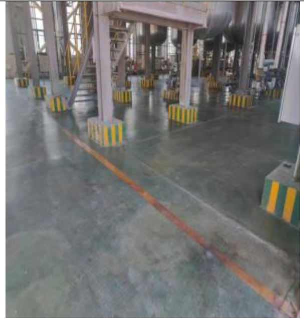
车间环氧树脂防腐
