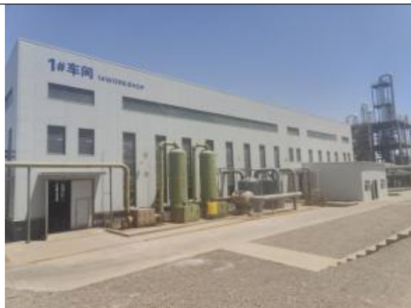
1#车间主体工程全景图
