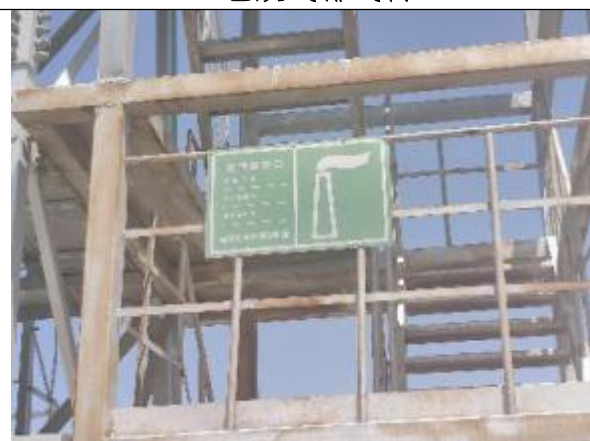
工艺废气排放口监测平台及标识牌
