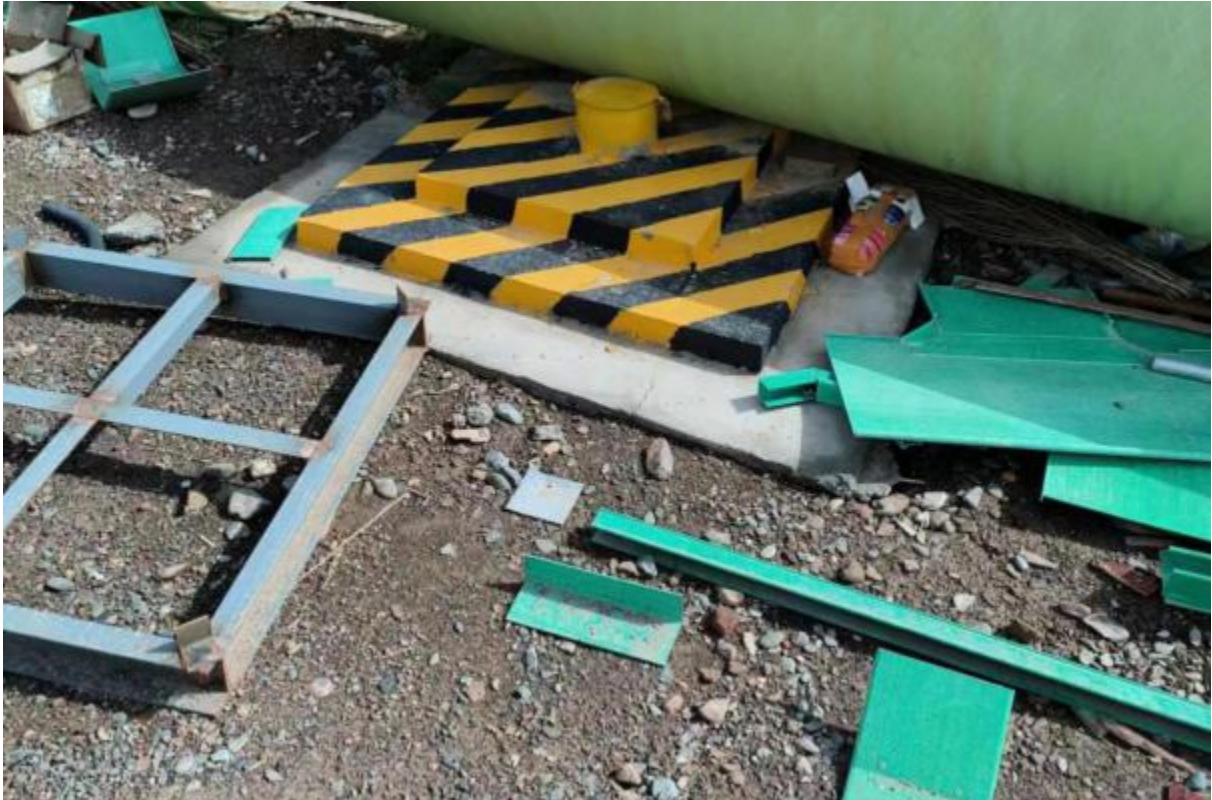
地下水监测井
