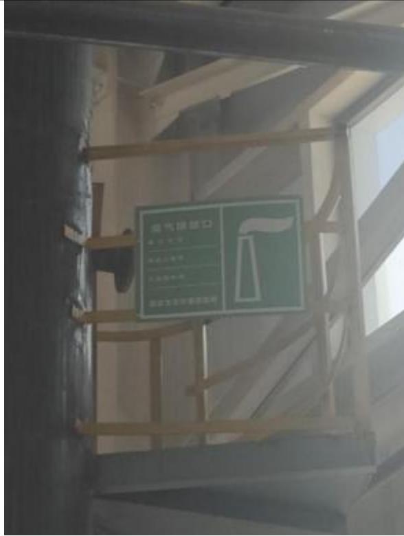
2#锅炉监测平台及标识牌
