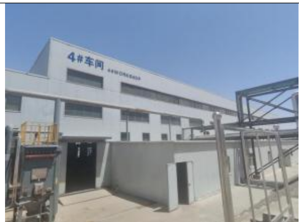
4#车间主体工程全景图
