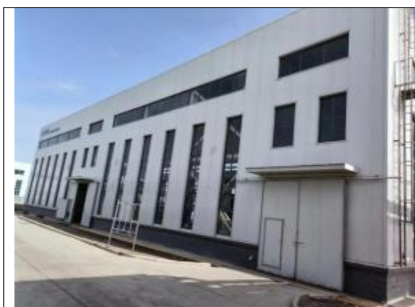
5#车间主体工程全景图
