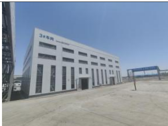
3#车间主体工程全景图
